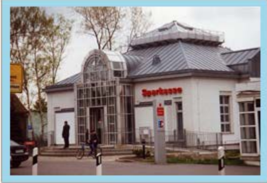
Neues Sparkassengebäude an der Knappenkampfbahn 1996 (Privatfoto)
