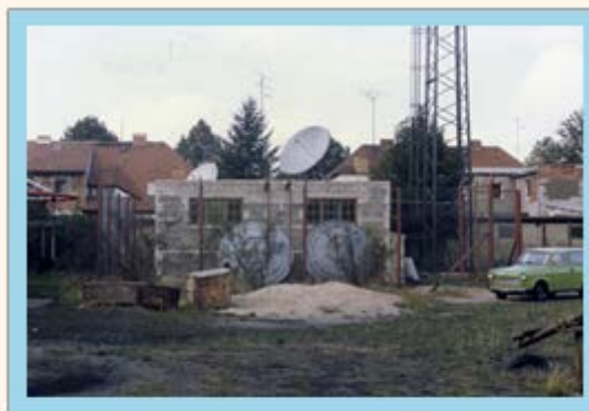
Bau der Kopfstation der Empfangsantennengemeinschaft 1989 (Privatfoto)
