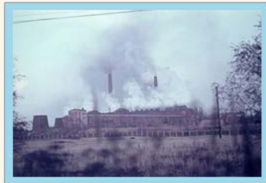
Brikettfabrik Knappenrode um 1980 (Privatfoto)
